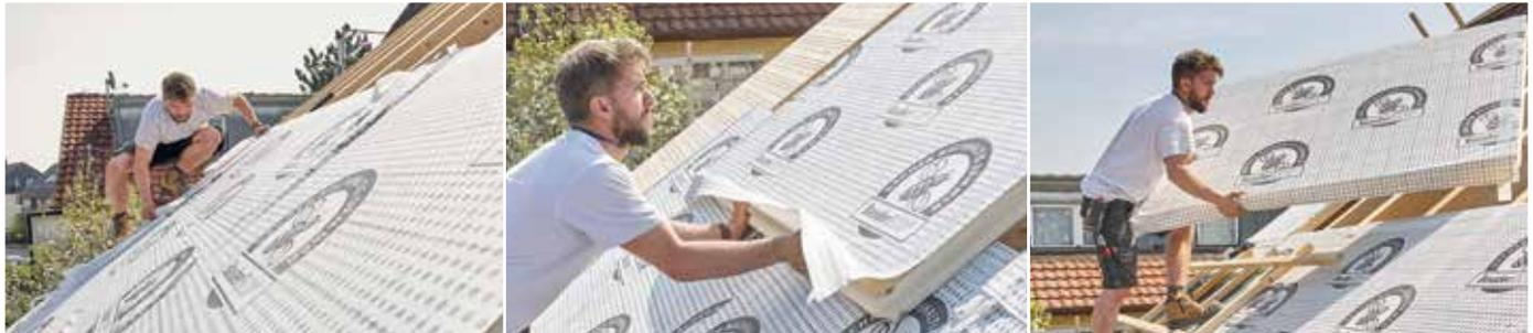
Verlegung von BauderECO als Aufsparrendämmung
