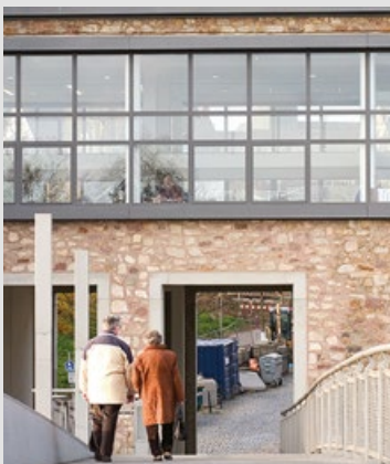
Vorhandene Portale neu integriert
