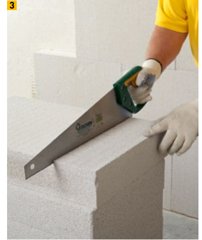
3 Multipor Mineraldämmplatte schneiden
