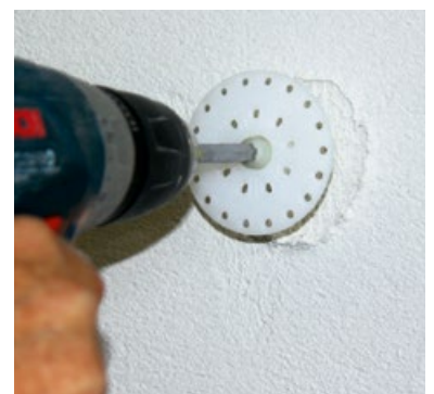
Setzen des Dübels durch das Gewebe
