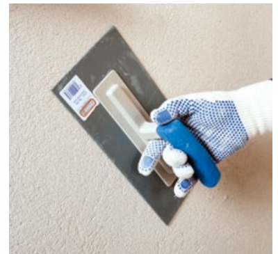
Strukturieren mittels Traufel
