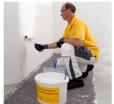
Auftragen der Multipor Innensilikatfarbe
