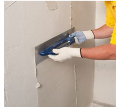
Aufziehen des Oberputzes
