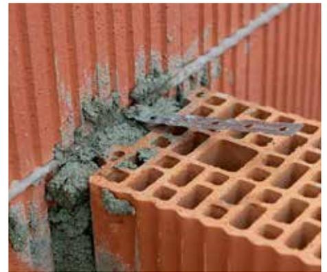
12. Innenwände werden Schicht für Schicht an die Außenwand herangemauert. Dabei müssen Sie die herausstehenden Flachanker in die Lagerfugen einbetten. Die Anschlussfuge muss satt vermörtelt werden (Mörtel bauseits, z.B. Quellmörtel).
