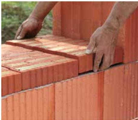
10. Geschnittene Ausgleichsziegel z.B. im Bereich einer Fensterbrüstung vermeiden Wärmebrücken.
