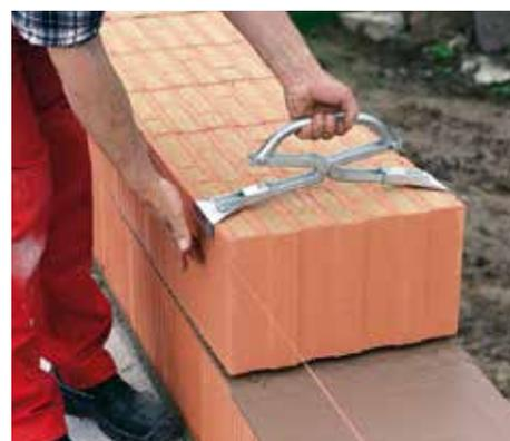
8. Wie gewohnt am Anfang und am Ende der Reihe einen Ziegel setzen und daran die Richtschnur anlegen. Dann Ziegel für Ziegel knirsch versetzen.
