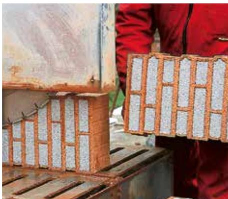
13. Schneiden vefüllter Ziegel mit der Nasssäge
