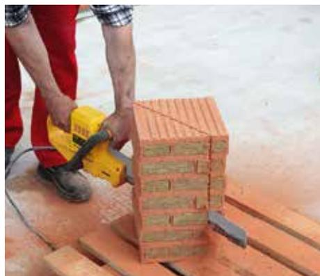
14. Schneiden mit der Handsäge
