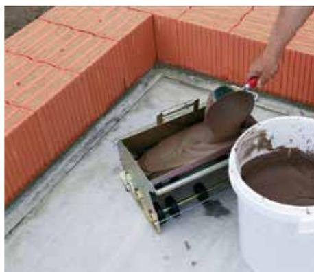
6. Jetzt wird die Mörtelrolle mit Dünnbettmörtel befüllt.
