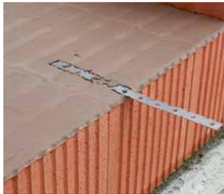
11. Vertiefen Sie zunächst die Lagerfläche der Ziegel an der entsprechenden Stelle mit einer Keramikfeile (Wienerberger Lieferangebot) um ca. 0,5 mm. Nach dem Aufrollen des Dünnbettmörtels werden die Flachanker an der vorbereiteten Stelle in das Mörtelbett einglegt.
