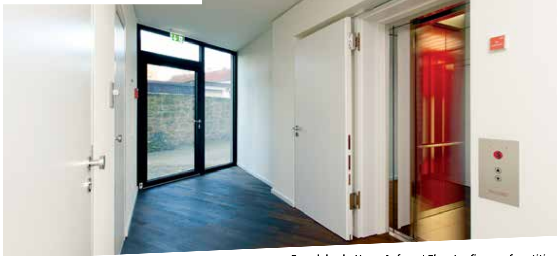
Brandabschottung Aufzug / Elevator fireproof partition Brandschutzelement mit Feststellung (Haftmagnet) Fire protection element with arrester (holding magnet)
